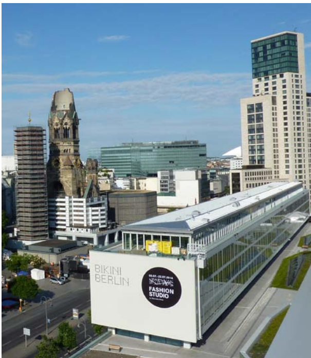
Abb. 8: Die Brandsicherheit des denkmalgeschützten und von 2010 bis 2014 umfangreich sanierten „Bikini Berlin“ wird unter anderem durch eine Brandschutzbeschichtung in F30 gewährleistet.
