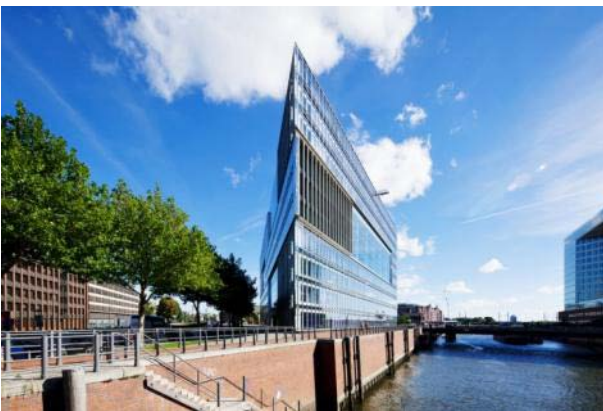
Abb. 2: Das 2002 erstellte zehngeschossige Gebäude „Deichtor-Center“ in der Hamburger Hafencity wird von einer F30-Brandschutzbeschichtung geschützt.
