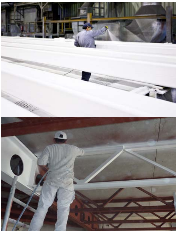
Abb. 14: Das Airless-Spritzverfahren sichert eine schnelle, gleichmäßige und wirtschaftliche Beschichtung. Es kann sowohl im Werk als auch vor Ort angewendet werden.
